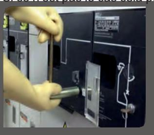
Attention en cas d'absence de mise à la terre : outre le risque de contact direct, les câbles peuvent être chargés par effet capacitif, et donc présenter un danger d'électrisation, voir d'électrocution. Une Vérification d'Absence de Tension (VAT) s'impose en cas de doute.
