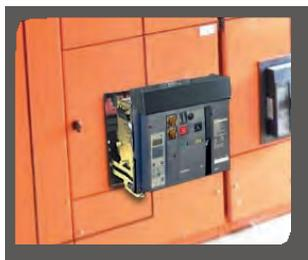
**Attention** : la simple manœuvre du disjoncteur n'est pas suffisante. Elle doit être associée au débrochage / sectionnement ou au sectionnement pour assurer votre sécurité (risque d'amorçage s'il n'y a pas débrochage).
