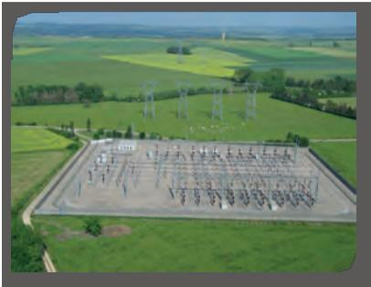
Le choix d'utiliser des lignes HT s'impose dès qu'il s'agit de transporter de l'énergie électrique sur des distances supérieures à plusieurs km. Le but étant de réduire les chutes de tension en ligne, les pertes et d'améliorer la stabilité du réseau. En effet, plus la tension est élevée, moins on aura besoin de « brassage » d'électrons, la même énergie est donc délivrée avec une plus faible intensité et donc des pertes sous forme de chaleur....
