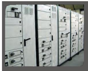
Cet organe de coupure peut être de 2 types : disjoncteur débrochable ou disjoncteur associé à un interrupteur sectionneur à coupure visible.
